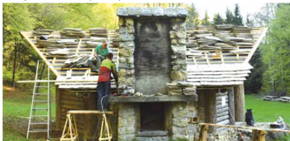
Lors des travaux de rénovations de la toiture en bardeaux
