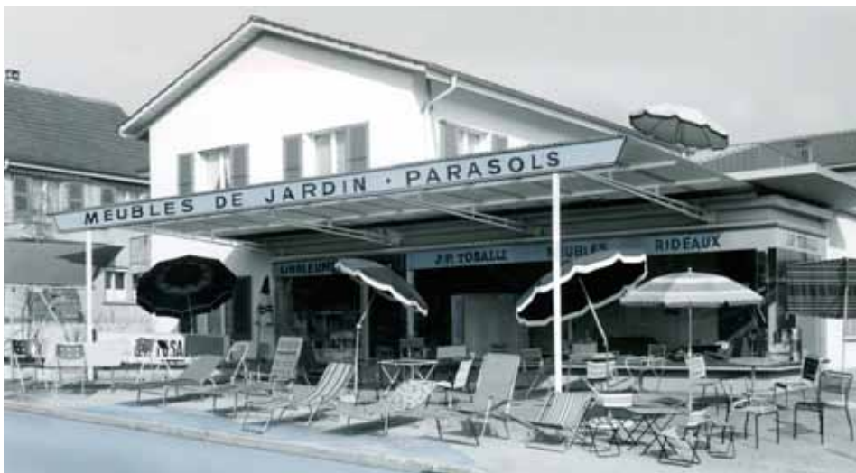
Le magasin Tosalli avec en plus du sport, la vente de meubles de jardin, parasols et stores solaires.
